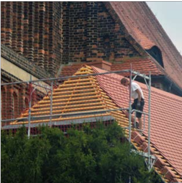
Von einer regionalen Firma ist die denkmalgerechte Neueindeckung des Daches ausgeführt worden.
